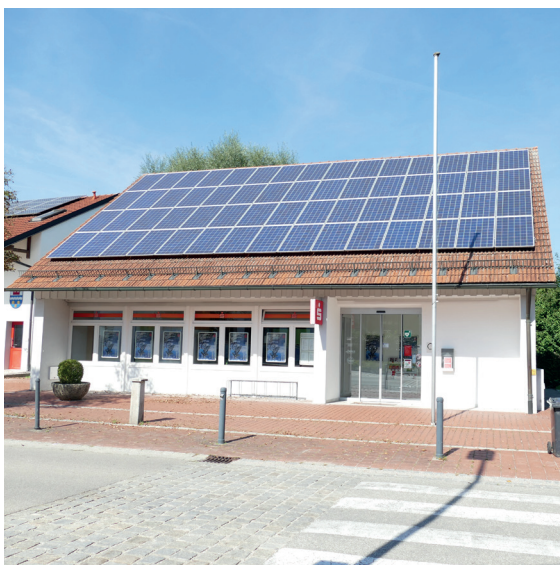
Abb. 45: PV-Anlage Sparkasse Langenbach
